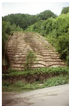
Stabilizare halda prin revegetare
