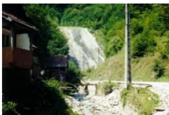
Foto 4. Îmbracaminte din beton de cimentcu metale grele realizata pe deseuri miniere
