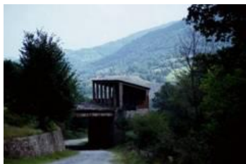
Foto 5. Drum pe sub rampa de încărcare
