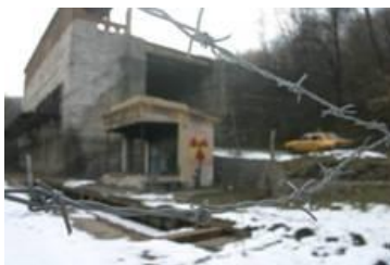
Foto 7. Ciudanovita- zona contaminata marcata
