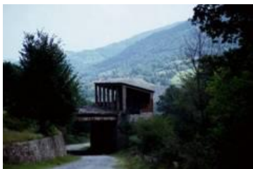
Foto 5. Drum pe sub rampa de încărcare
