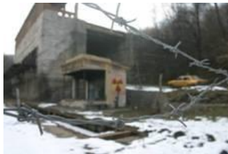
Foto 7. Ciudanovita- zona contaminata marcata
