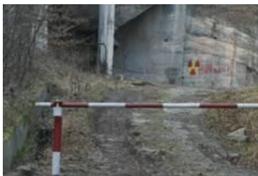
Foto 8. Ciudanovita – zona contaminata marcata
